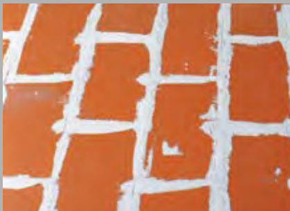
Nicht sichtbarer „ESTRICHZIEGEL“ unter Fliesenverlegung.
