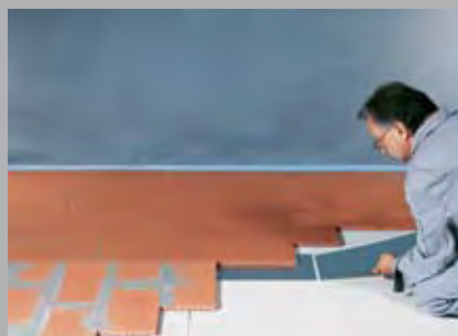
Wechsel des Verlegebildes
