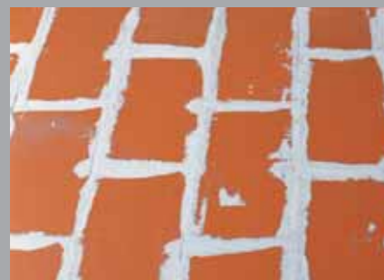
Zakryté „ESTRICHZIEGEL“ pod položenými dlaždicami.
